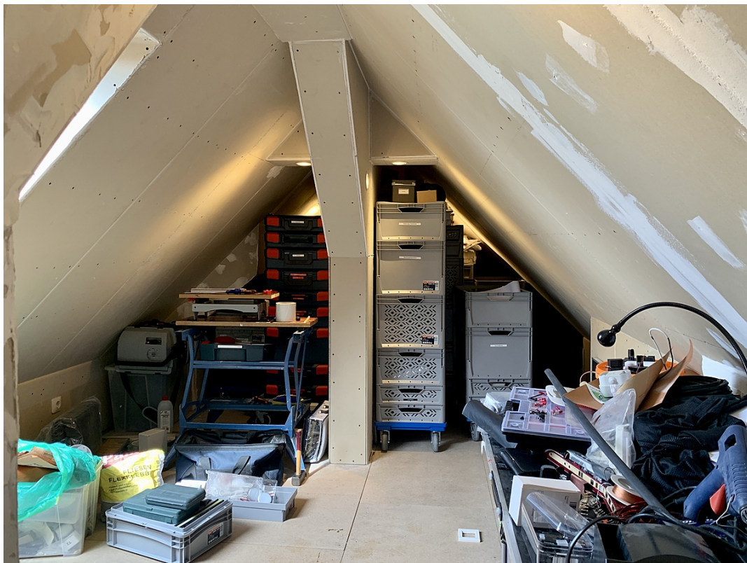
Dachboden - teilw. ausgebaut
